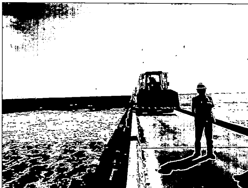
FOTO 03: Supervisor a la altura de eje 167
